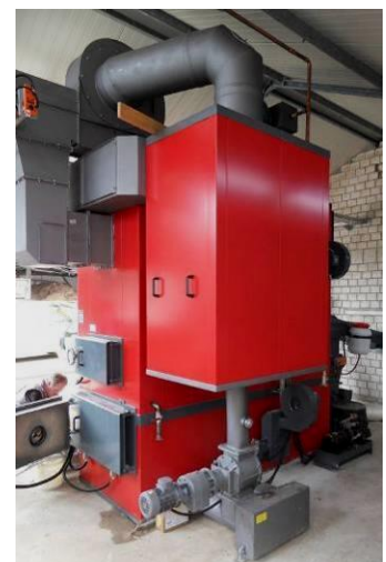
Шлюзовый затвор на позиции передачи золы
